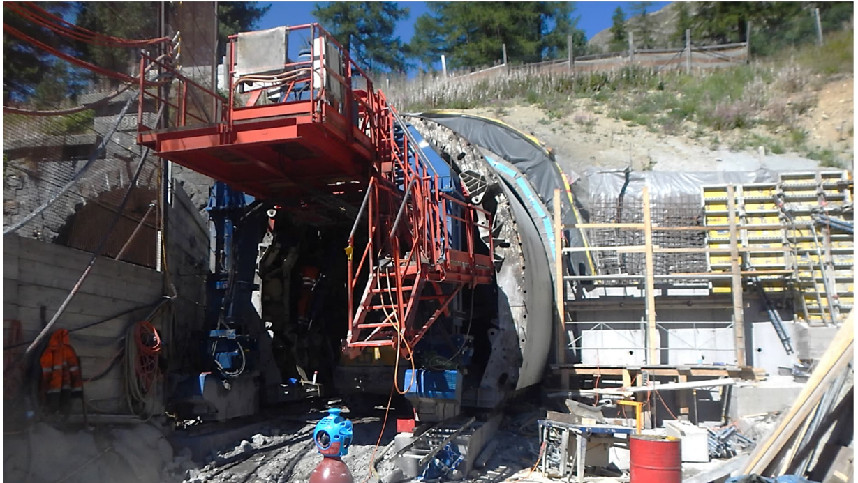
Neuer Albulatunnel im Rohbau; Ortbetongewölbe am Portal in Spinas angekommen.
