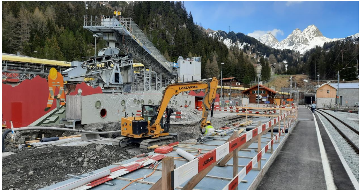
Umbau Bahnhof Preda
