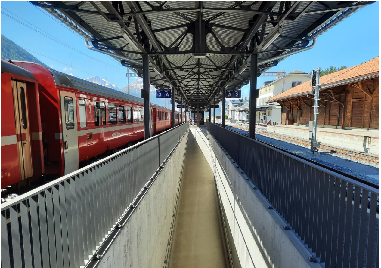
Mittelperron mit Rampe Bahnhof Bever
