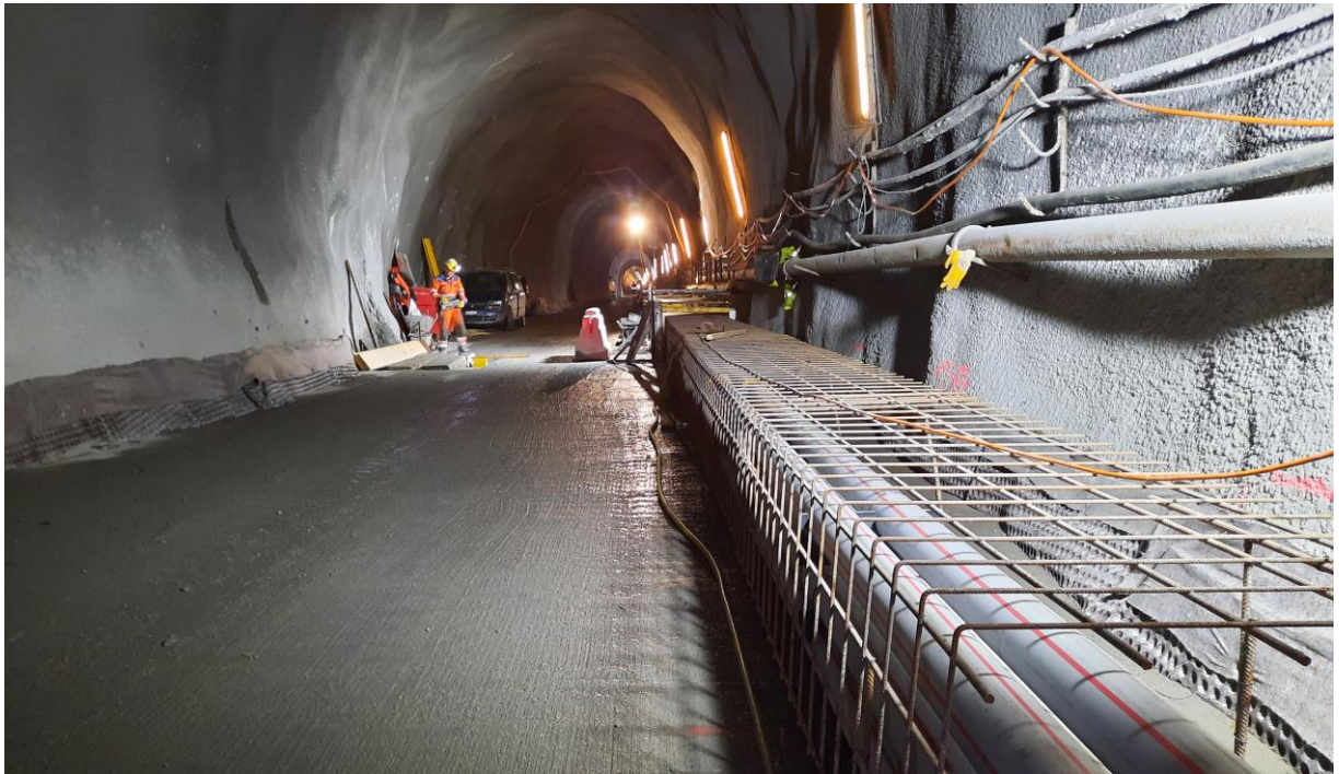
Sohlen-/Bankettausbau in der Tunnelstrecke mit einschaliger Gewölbeverkleidung, März 2021
